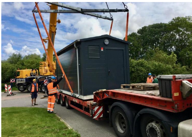
Figur 5. Illustration af bygning til transformer/switchgear og teknikbygning
